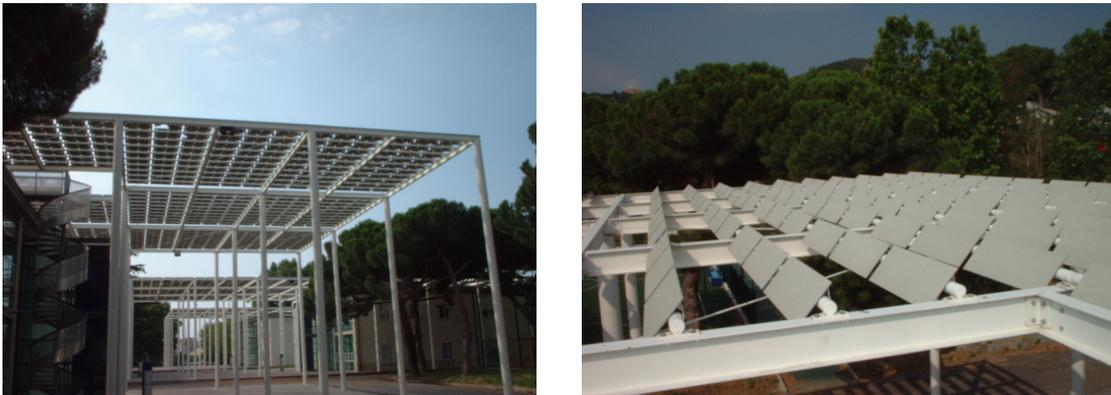
Per prima cosa si è cercato sul mercato del fotovoltaico l'esistenza di pannelli adatti alle esigenze architettoniche del caso specifico: essendo i frangisole molto piccoli si sono trovati solamente 3 pannelli adatti al progetto in esame. Trattasi di:
